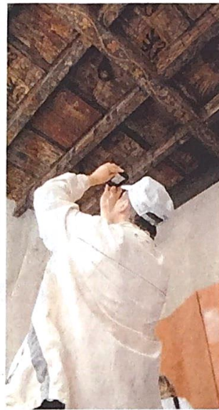
Balkendecke im Qvest Hotel BILDER: PETER RAKOCZY
